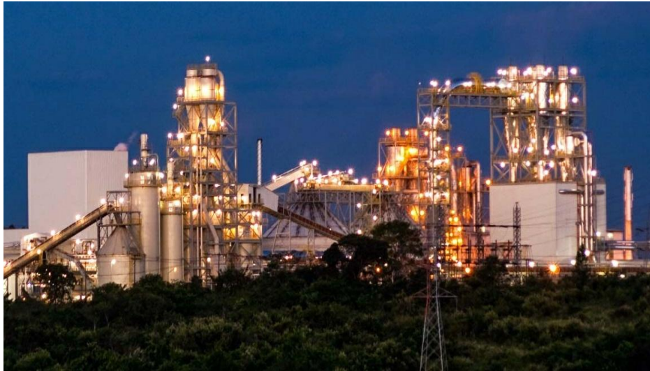
Figura 12: Vista parcial da planta foco do estudo
